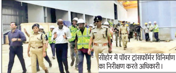
सीहोर में पाँवर ट्रांसफॉर्मर विनिर्माण का निरीक्षण करते अधिकारी।
